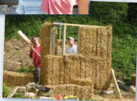
Démonstration construction paille ▼
