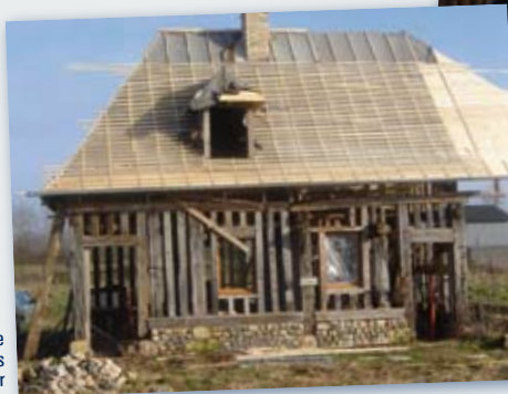
Maison à colombages après remise d'aplombs et ouvertures GRETA du Calvados - site de Honfleur
