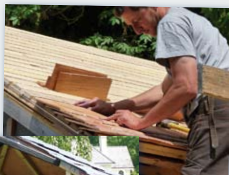
Pose de bardeaux ▲
