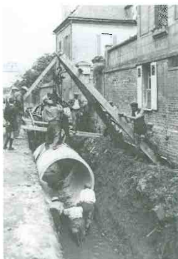
Pose d'une canalisation d'eaux pluviales, rue du Carel en 1930
