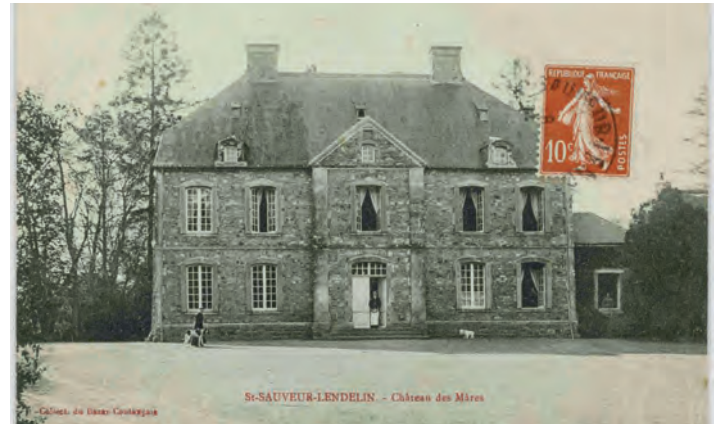
→ Le château des Mares de Saint-Sauveur-Lendelin qui a servi d'état-major en août 1944.
