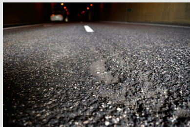
Revêtement goudronné d'une chaussée contenant de l'amiante
