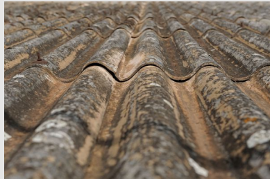
Toiture amiantée en fibrociment
