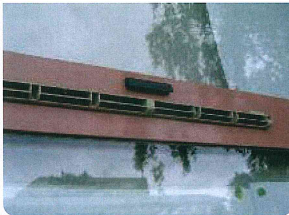
Photo 8 : Entrée d'air dans une fenêtre
