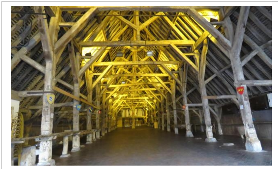
Le chantier de rénovation des Halles va donner lieu à un projet pédagogique.
