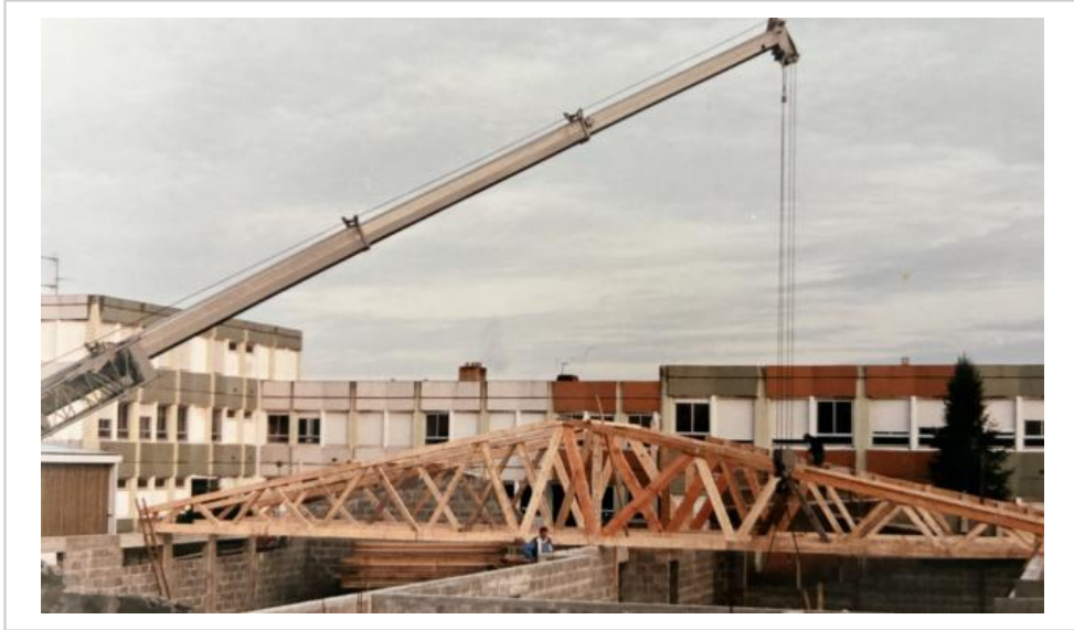
La construction du lycée
