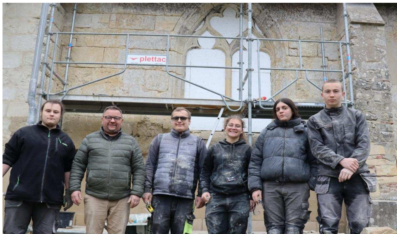
Cinq lycéens de l'établissement Victorine-Magne travaillent à la restauration d'une partie de l'édifice religieux. Ils sont encadrés par leur professeur, Sébastien Bride (2e à gauche). Ouest-France
