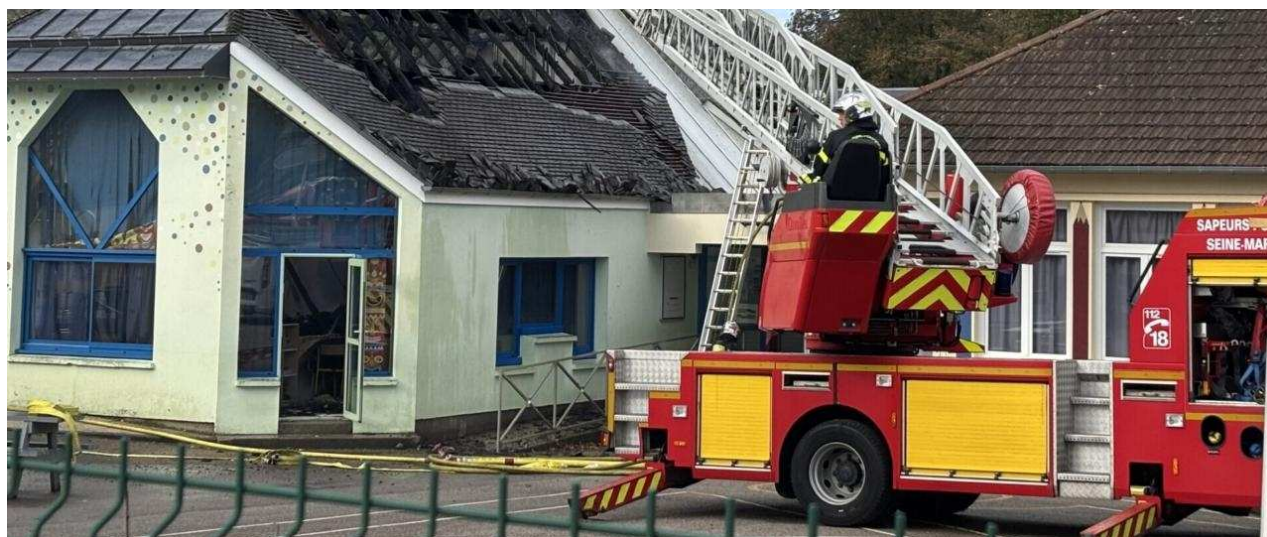
Le toit a pris sous la toiture, à l'occasion d'un chantier. Isabelle VILLY
