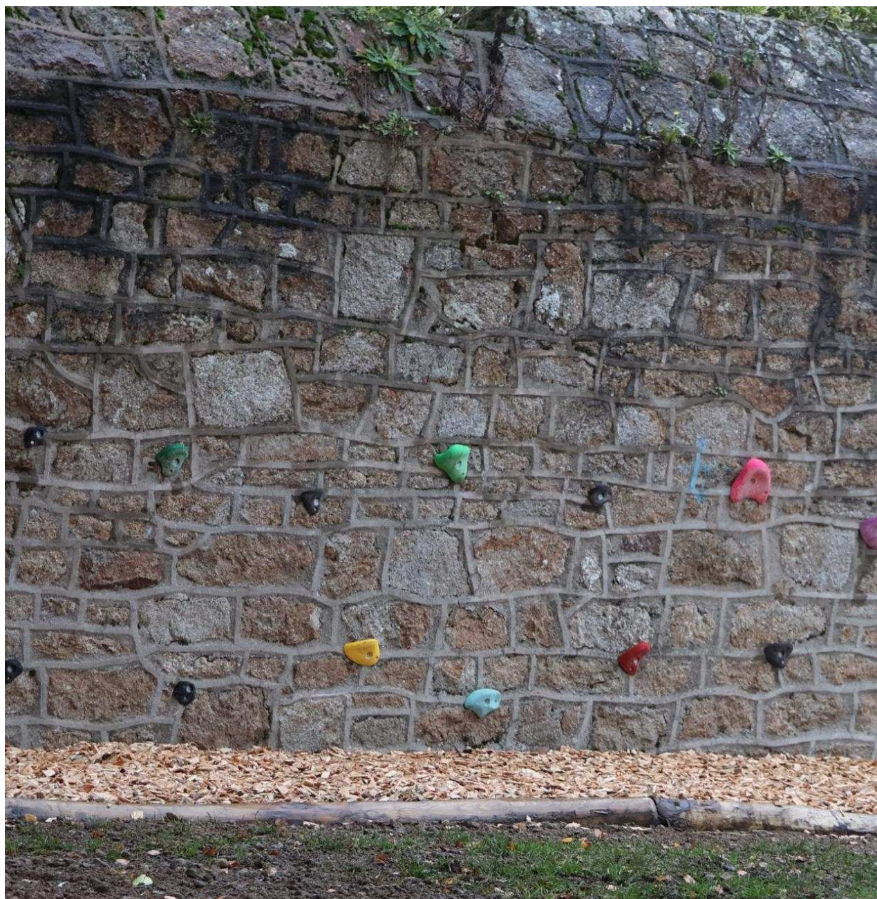
Des prises d'escalade ont été installées sur un mur. Ouest France
