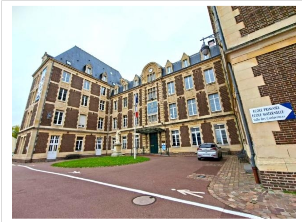
L'édifice emblématique de Saint-Joseph à Caen, rue des Rosiers, et datant de 1885.
