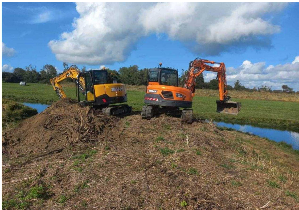
Le site du domaine de Beauguillot, à Sainte-Marie du Mont, en travaux. DR
