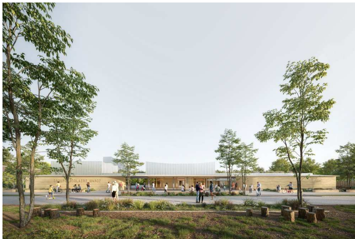
La devanture du groupe scolaire Clément-Marot, après sa réhabilitation et restructuration. - ACAU
