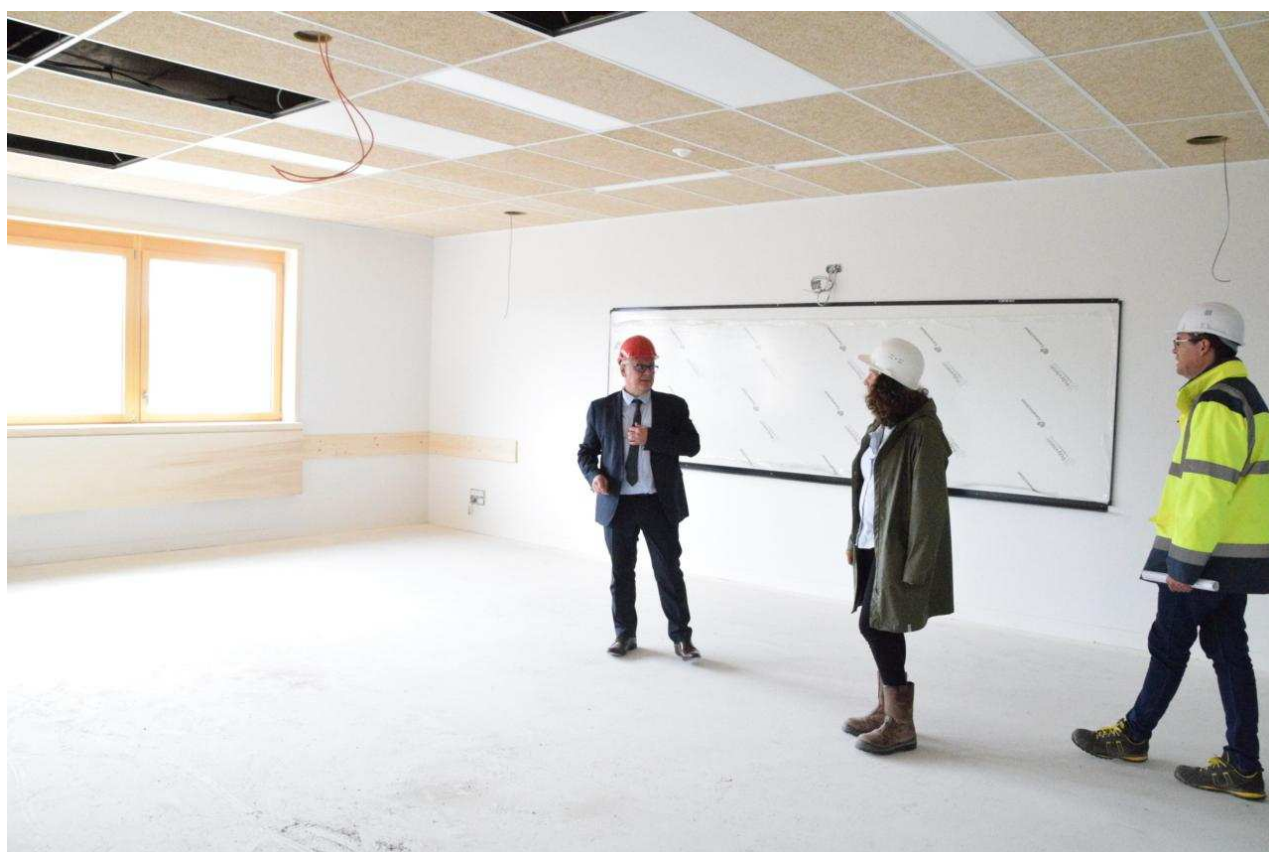
Le principal Philippe Paris et les agents d'Orne habitat chargés du chantier. L'Orne hebdo / KP
