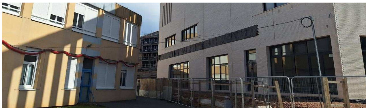
L'ancien et le nouveau collège cohabitent dans la même cour.
