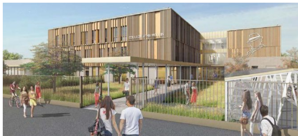
Ce à quoi ressemblera le Collège Jean Moulin à Caen, après la fin des travaux en 2029. Département du Calvados
