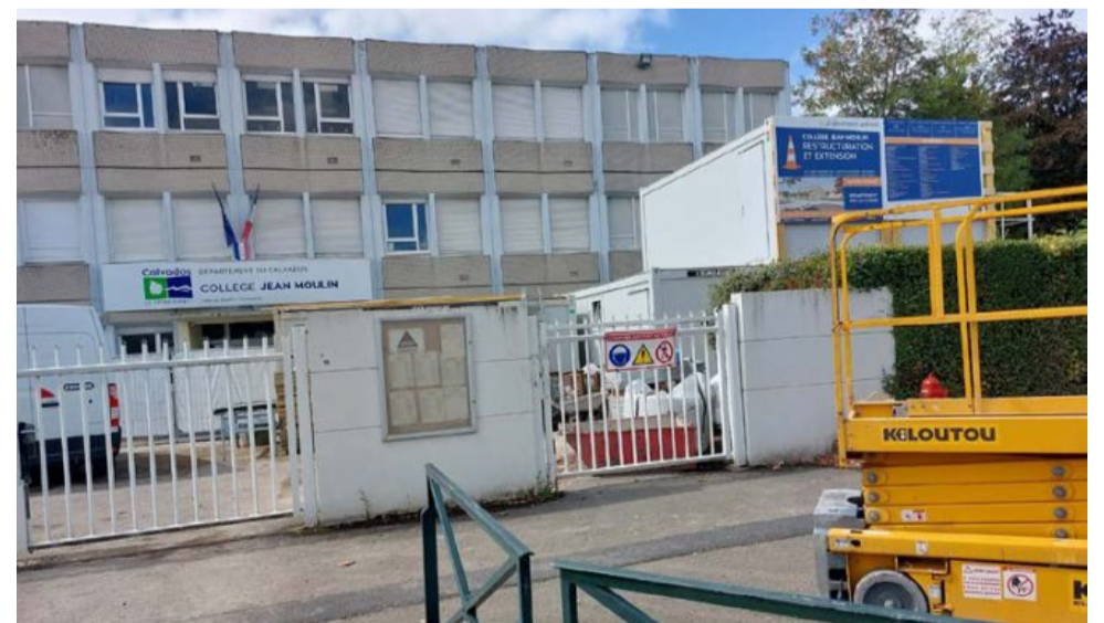
Alors que la rentrée des classes approche, des travaux de rénovation suivent leur cours à l'école Jean Moulin à Caen (Calvados). Nicolas Claich
