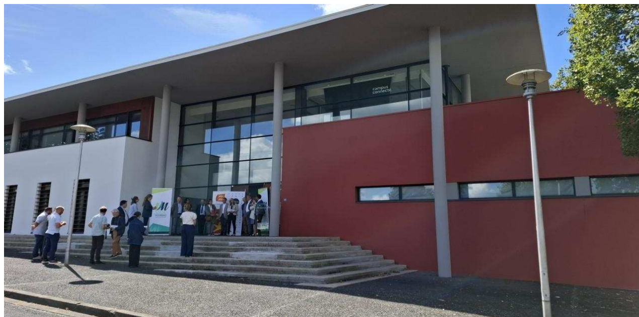
Nouvelle façade pour le site de l'IUT. Ouest-France
