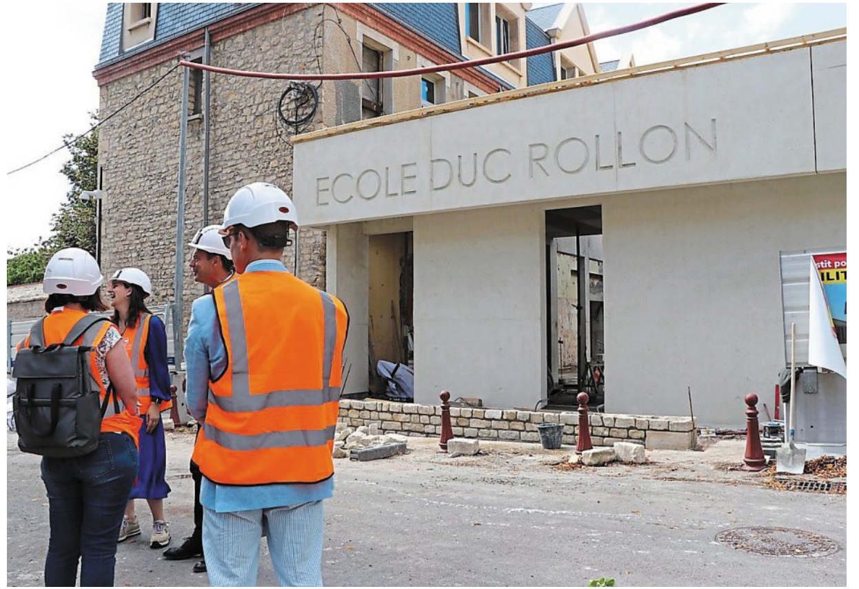
L'école maternelle Duc-Rollon est en travaux de rénovation et de construction. Elle accueillera, à partir de la rentrée 2026, l'école élémentaire Bicoquet.
