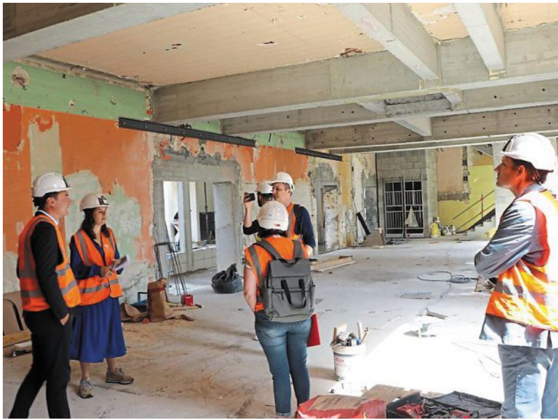
L'école Bicoquet et l'école Duc-Rollon, ici en chantier en cette fin d'été 2025.
