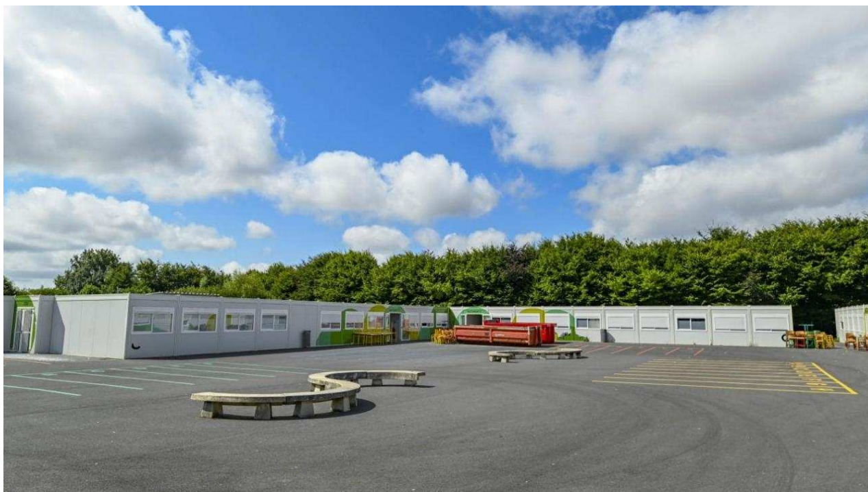
Le collège provisoire doit être démonté. C'est sur ce terrain que le sport était pratiqué avant que le collège provisoire ne s'y installe. Photo Boris Maslard/Paris Normandie
