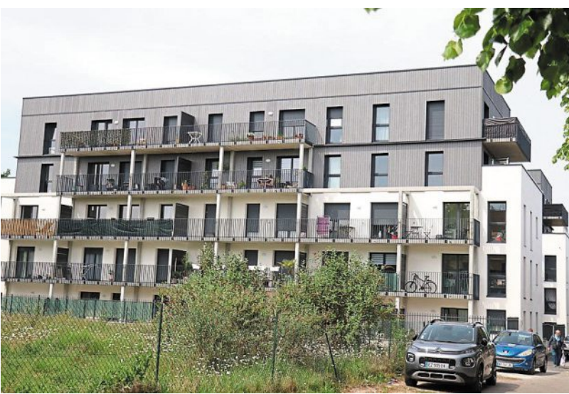
Un des immeubles livrés en cette année dans le quartier Rethel à Caen.
