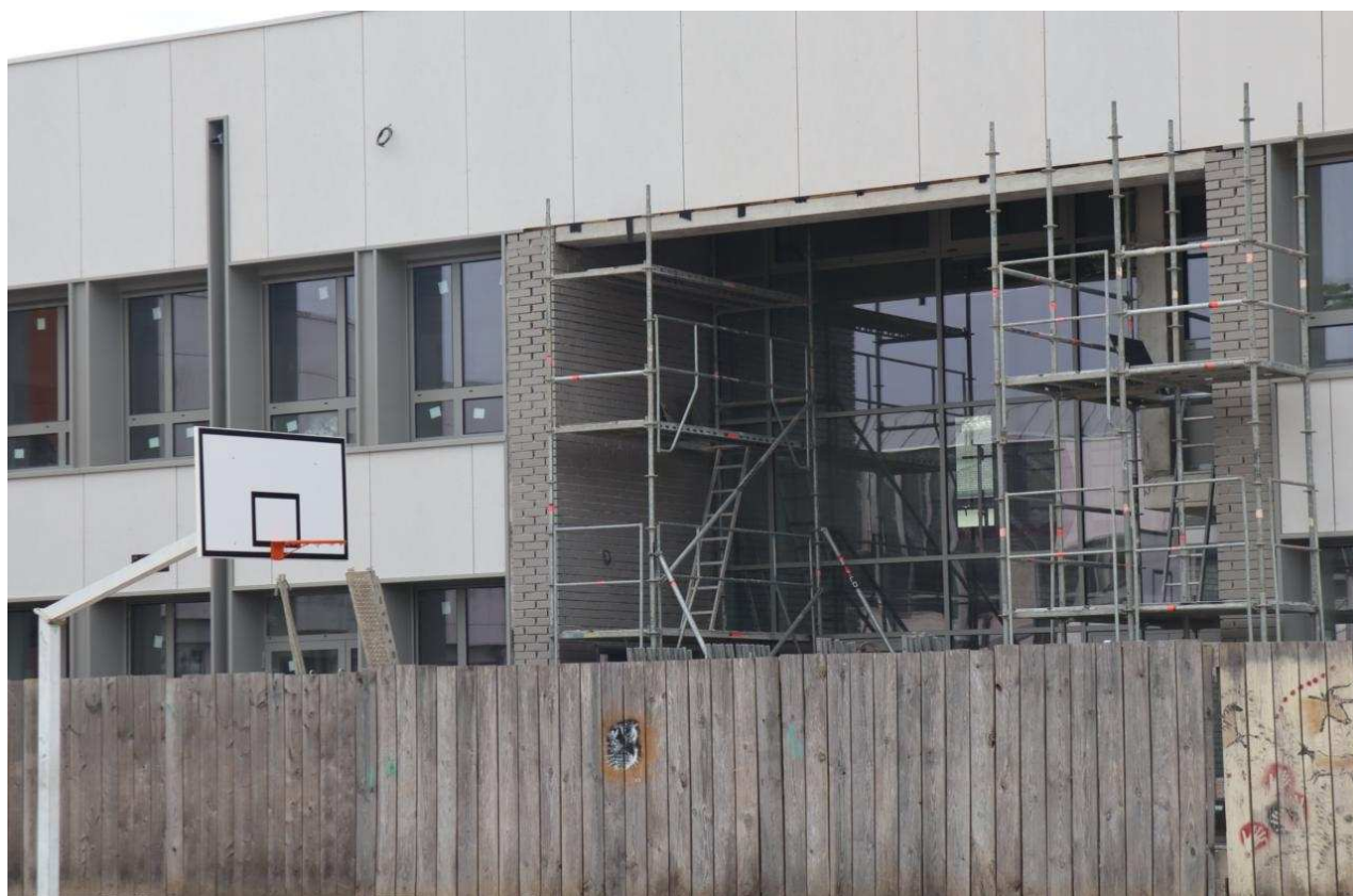
Les travaux ont débuté à l'été 2022. Ouest-France
