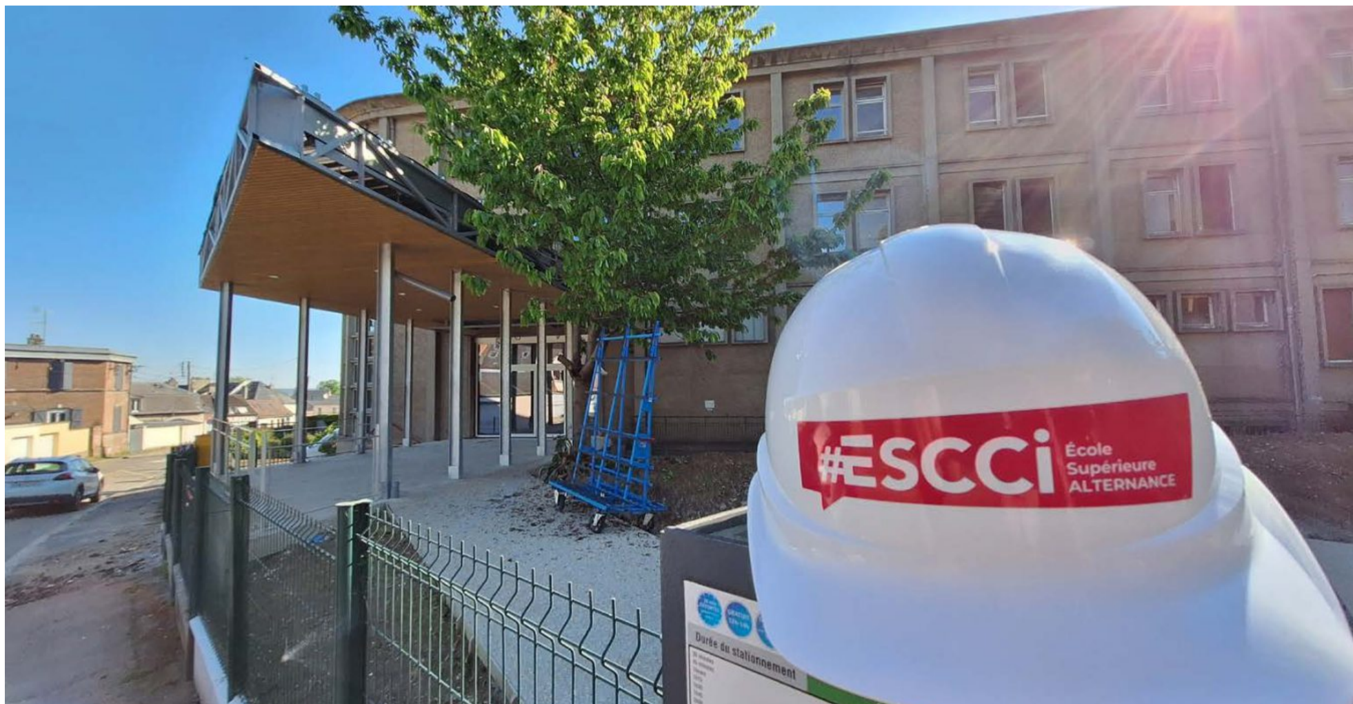
Après deux ans de travaux de mises aux normes et d'aménagement, le nouveau campus de l'ESCCI se prépare à l'ouverture. Charles GIOVACCHINI
