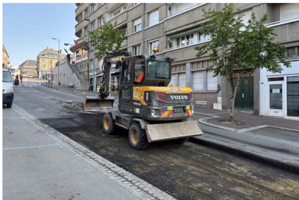
La réfection de l'enrobé est réalisée par le département.
