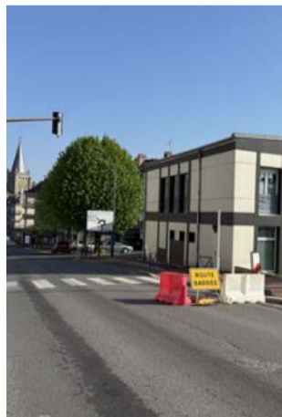
La déviation débute face au Pôle du Colombier de ce côté du chantier.
