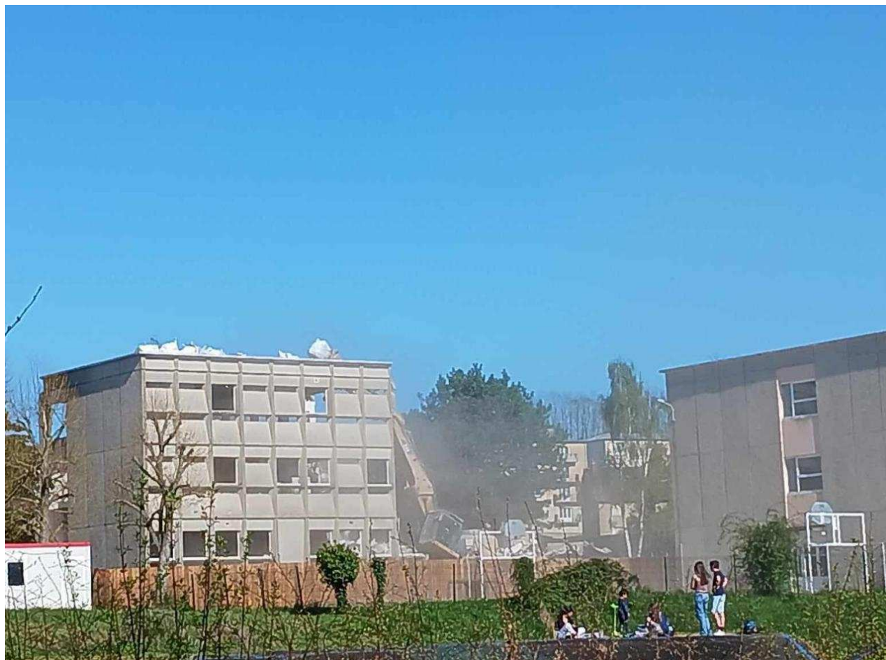
La pelleuse est venue à bout de l'ancien bâtiment Segpa en à peine deux jours
