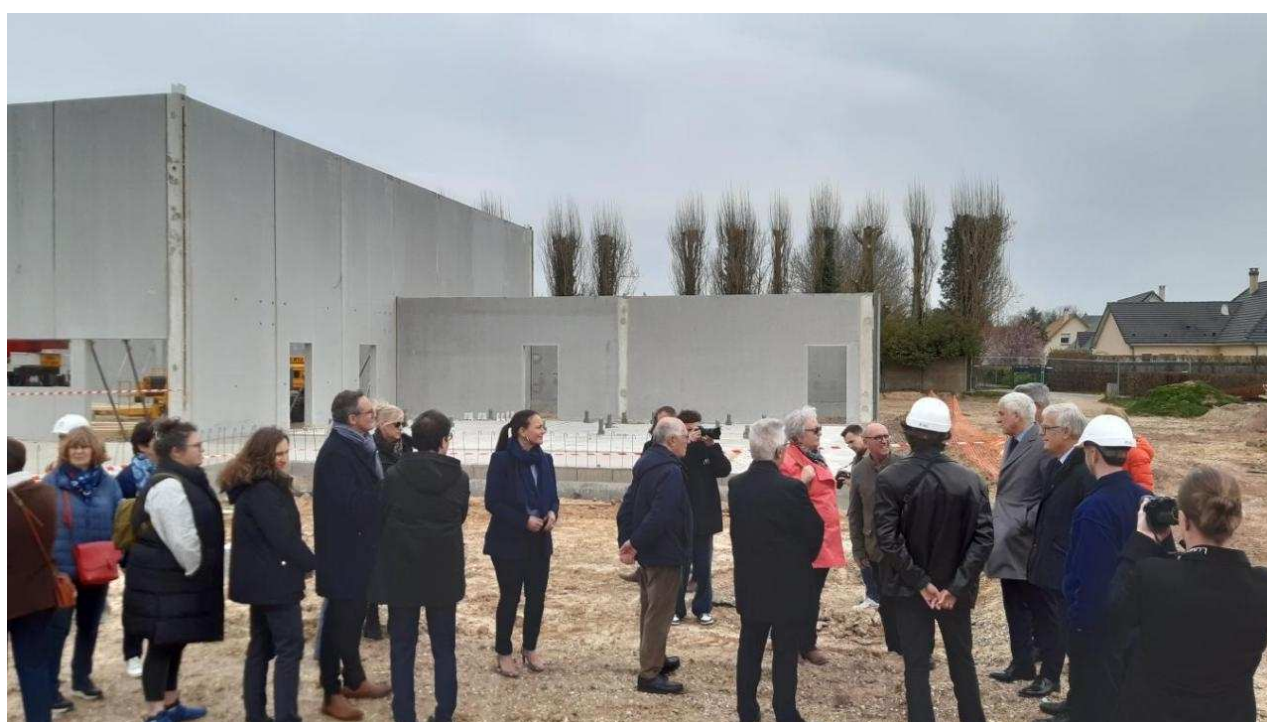
La visite du chantier a permis d'évoquer le futur du lycée international Photo Paris Normandie
