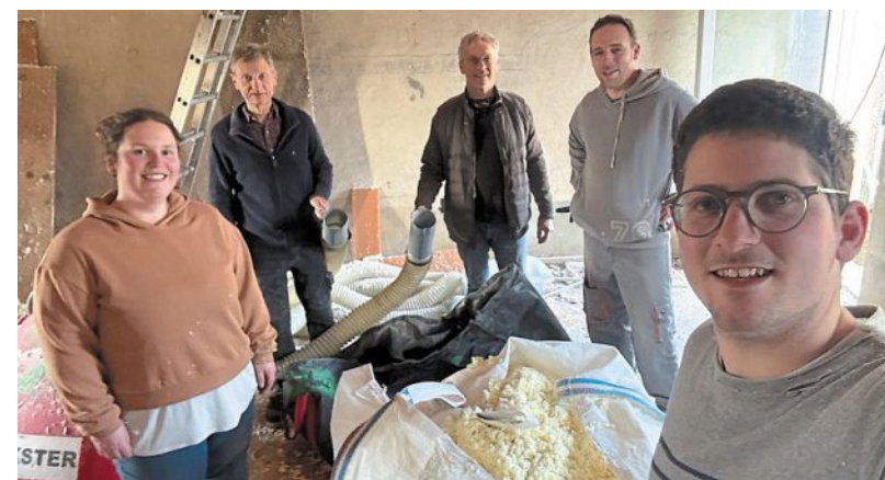
Aurélien Marie, coordinateur du tiers-lieu L'Arbre, et des bénévoles sur le chantier de la future objéthèque.
