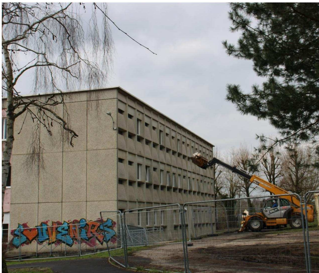
Durant les vacances, l'ancien bâtiment Segpa est vidé de tous les matériaux qu'il contient. Ouest-France
