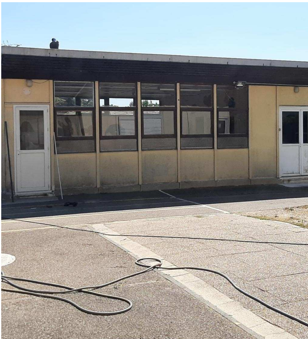
L'ancienne garderie, démolie cet été, a été remplacée par des bâtiments modulaires pouvant accueillir la 5e classe. La Dépêche de Louviers – Pierre CHOISNET – archive
