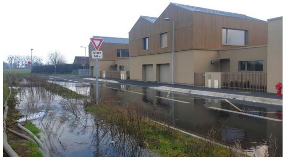
Les pompiers ont pompé l'eau pour l'extraire des sous-sols de la cantine du collège de Bourneville-Sainte-Croix (Eure). EG
