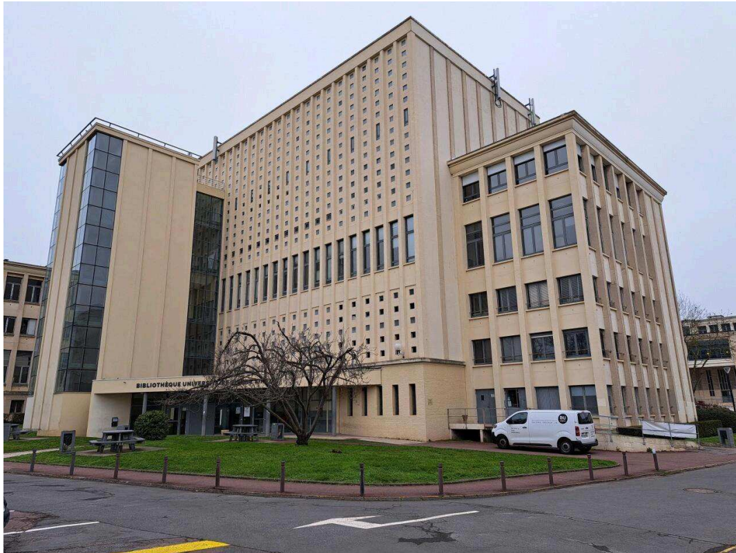
Le bâtiment C qui accueille la bibliothèque Pierre Sineux va être rénové.
