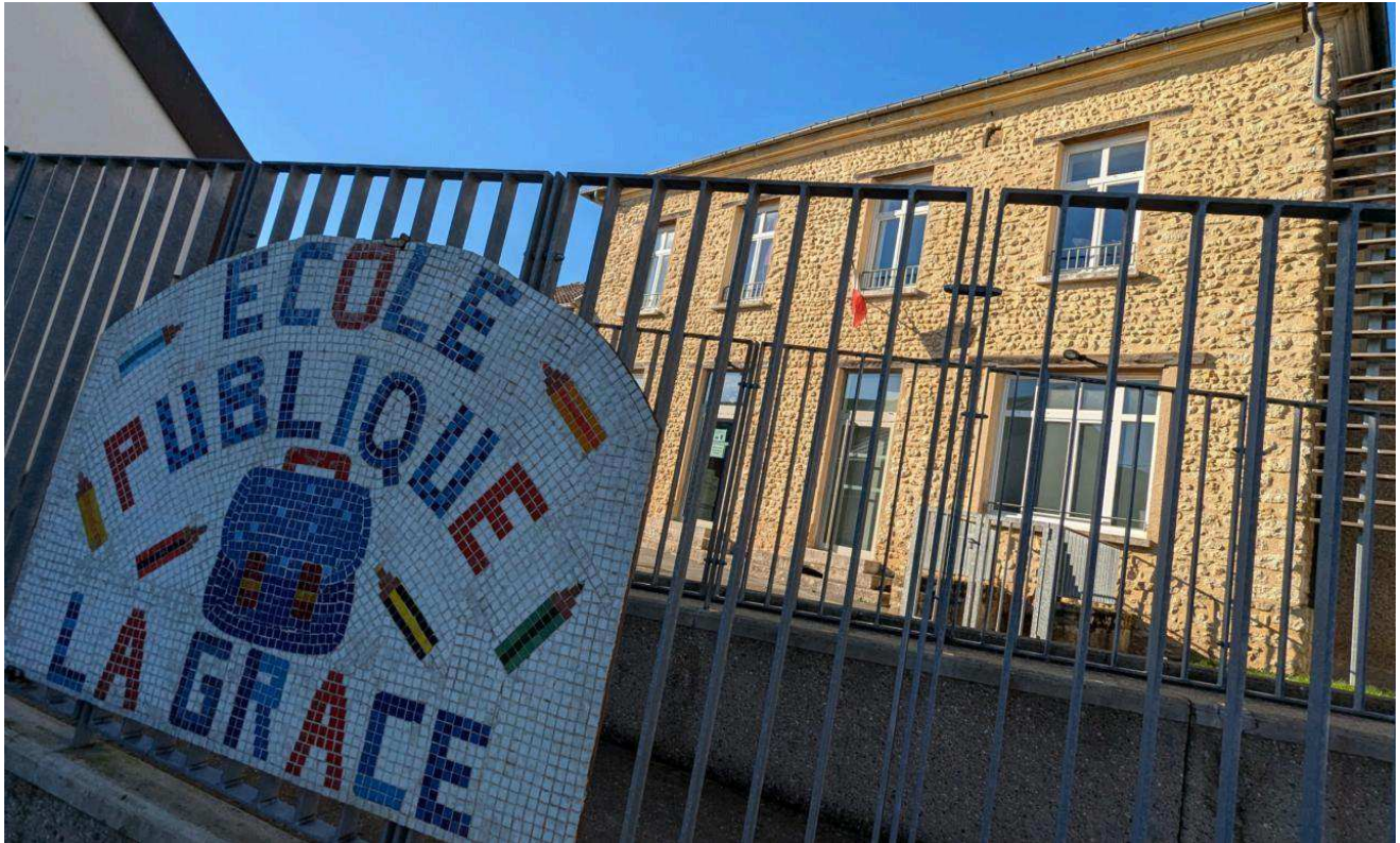
L'école de Saint-Pierre-de-Bailleul a connu une panne de chaudière en ce début d'année.
