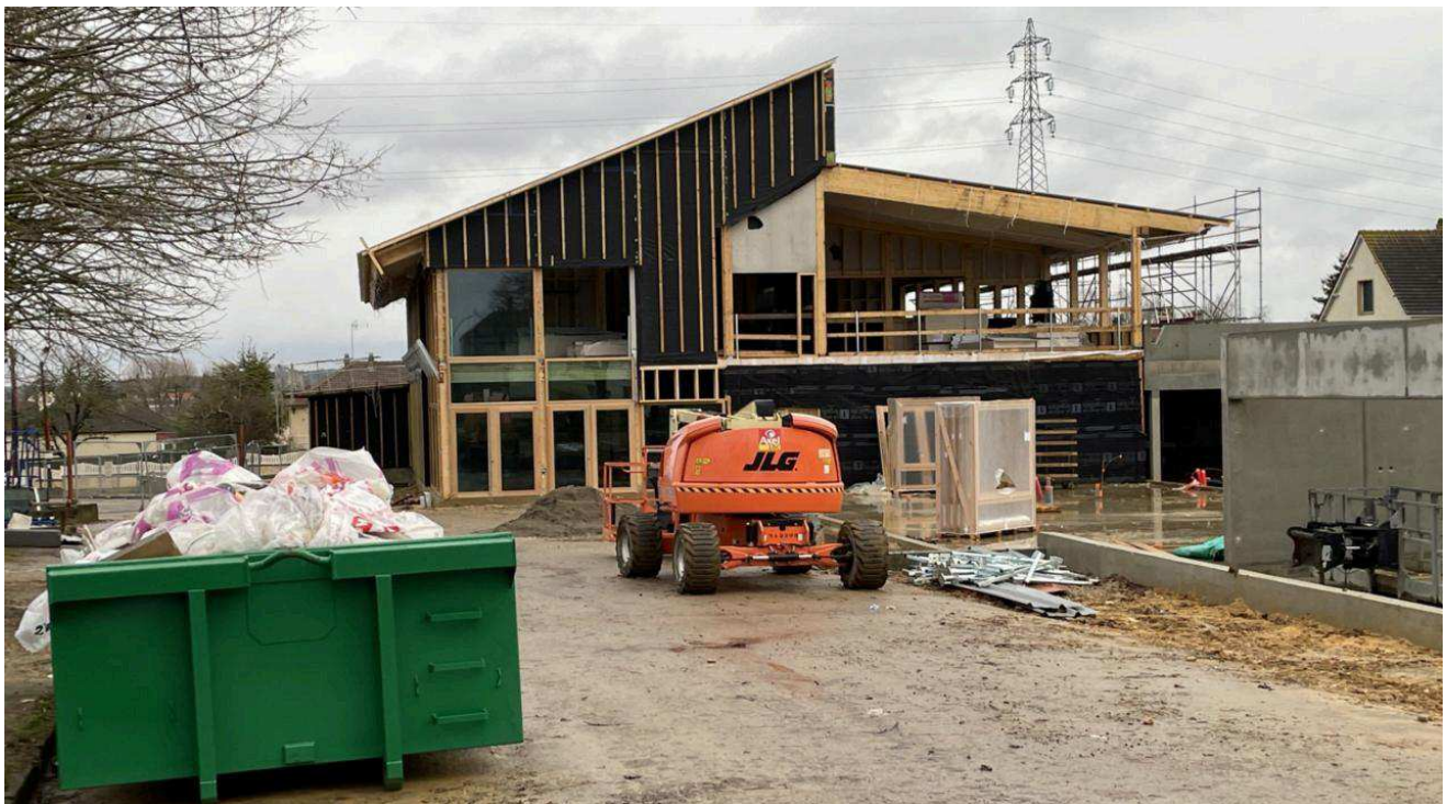
Le chantier de la future école du quartier Vallée d'Auge a pris du retard. Ouest-France
