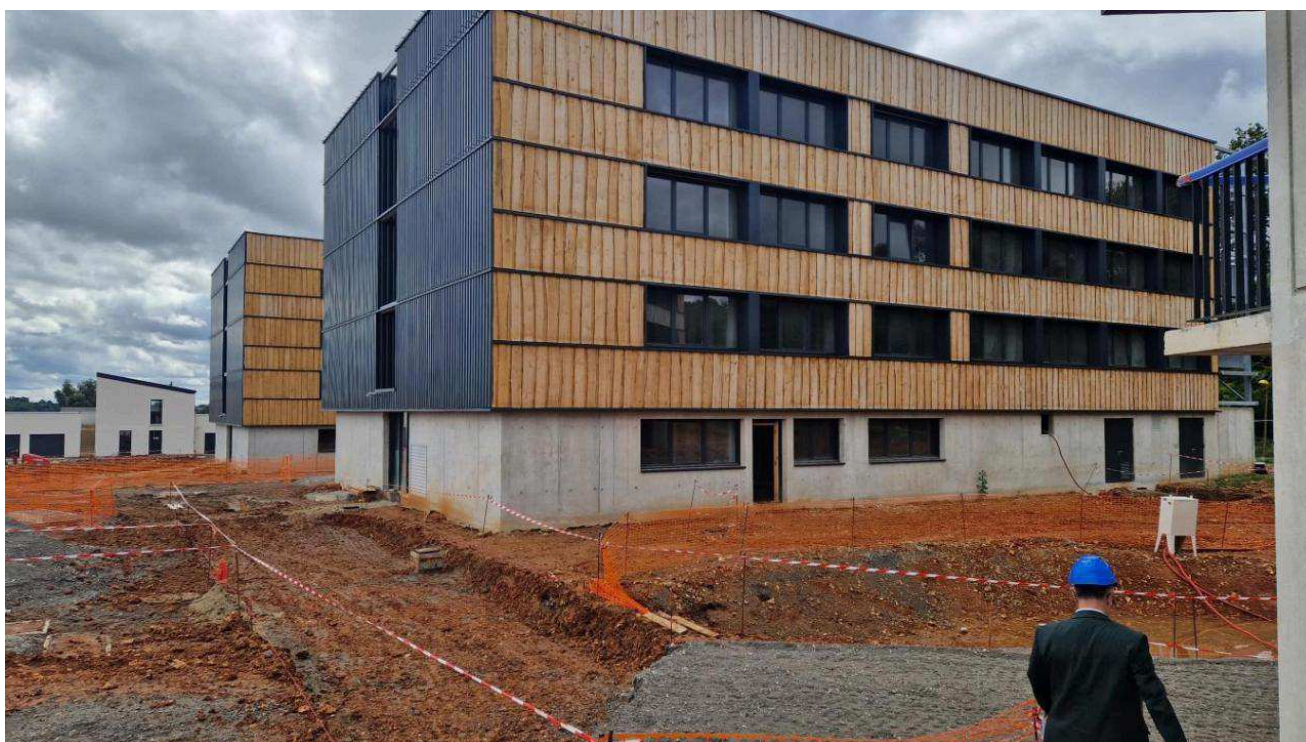
Une expertise doit être menée afin de chiffrer les dommages et trouver les causes du sinistre. Photo d'archives Paris Normandie
