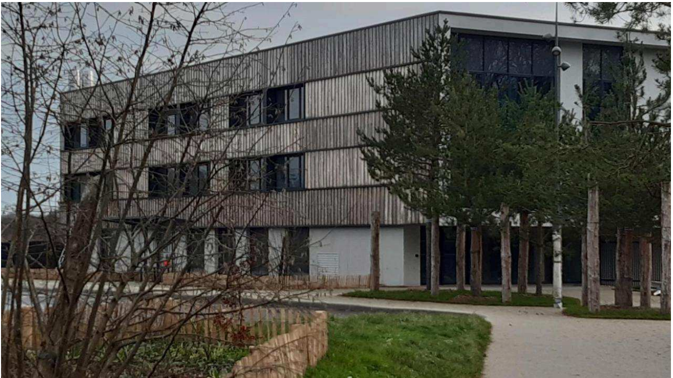
L'ouverture du lycée international de Bourg-Achard est reportée sine die Photo Paris Normandie
