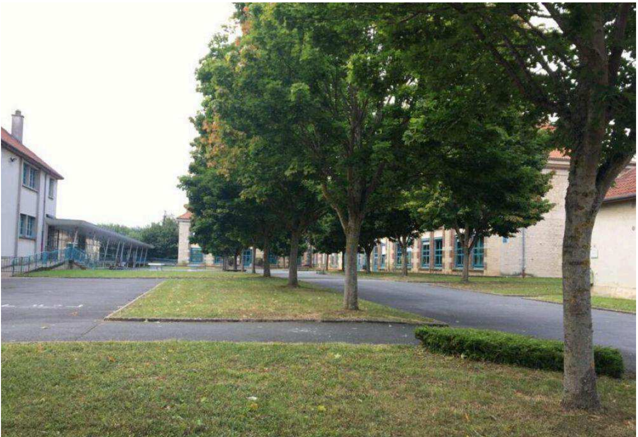
Le chantier du collège François-Truffaut d'Argentan va débuter en 2025. Archives Le Journal de l'Orne
