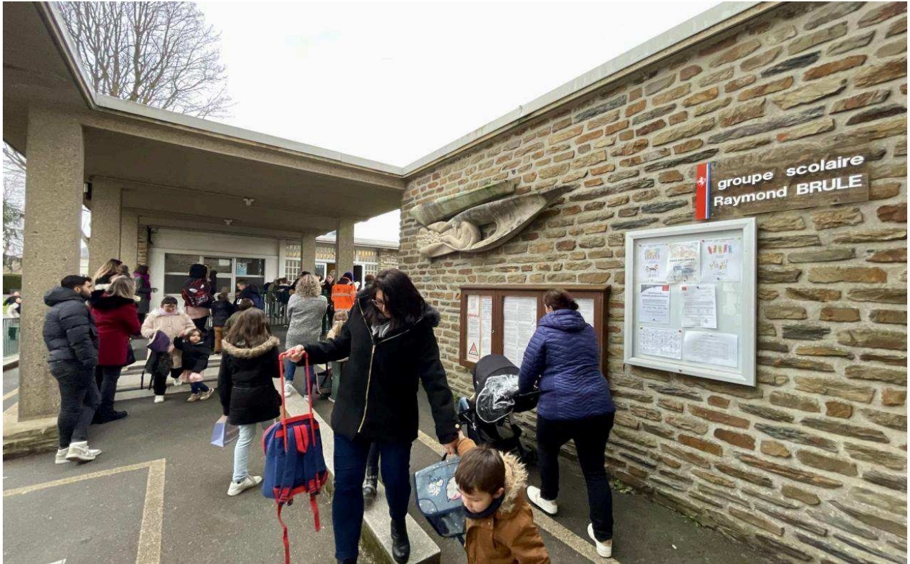
Une vaste réfection est en cours à l'école Raymond-Brulé de Saint-Lô. Archives Ouest-France
