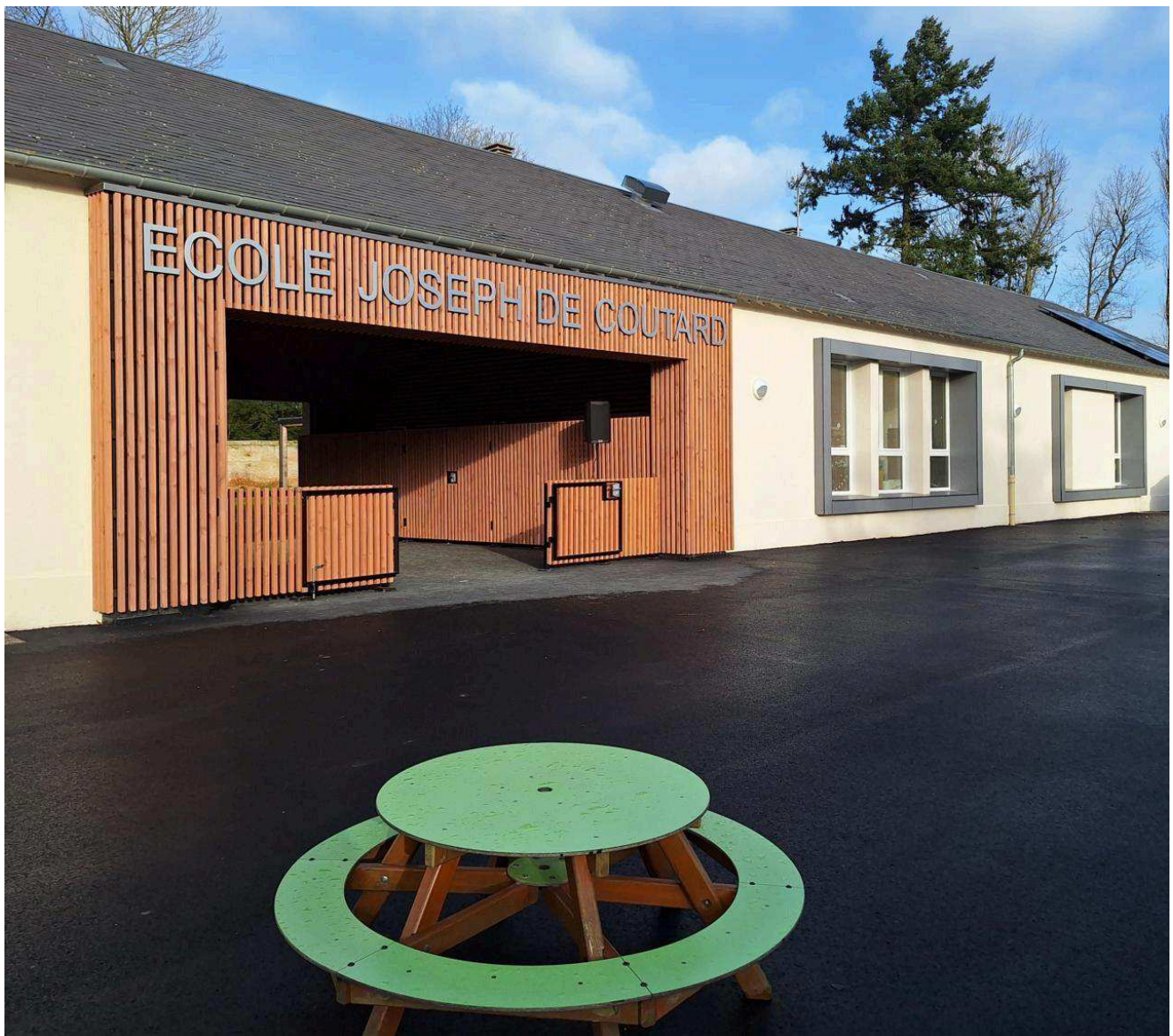
La façade a été refaite. AW / Liberté Caen
