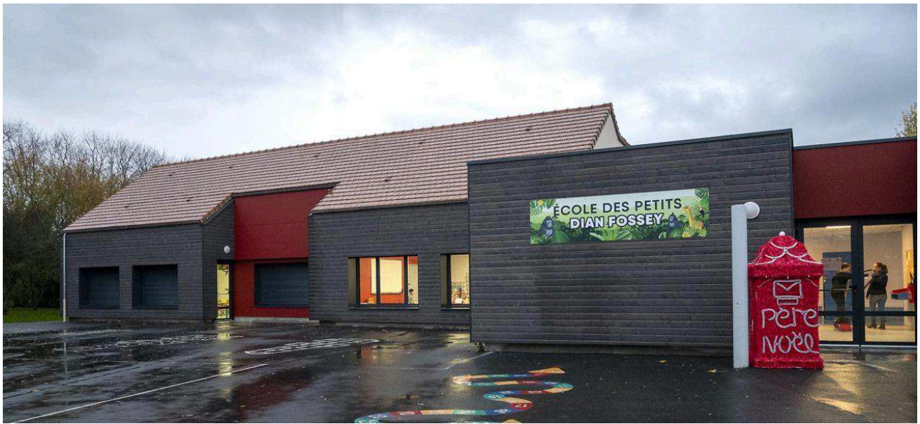
Les travaux de rénovation énergétique de l'école Dian-Fossey sont terminés. Ouest-France
