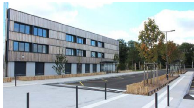
Malgré l'arrêt des travaux sur le bâtiment principal, la construction des internats et l'aménagement des extérieurs ont pu se poursuivre. S.F
