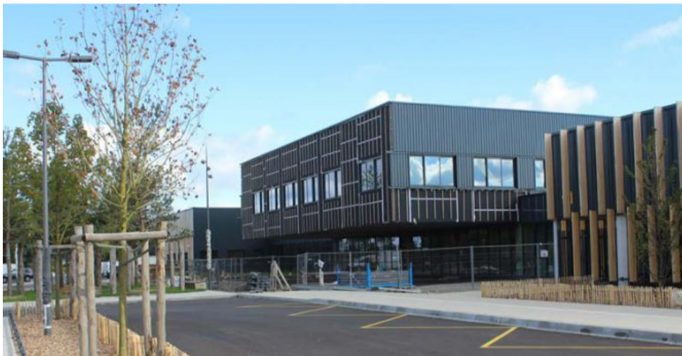
Les travaux entrepris sur le bâtiment principal ont dû être stoppés en raison de fissures apparues sur des poutres, au niveau de la charpente. S.F
