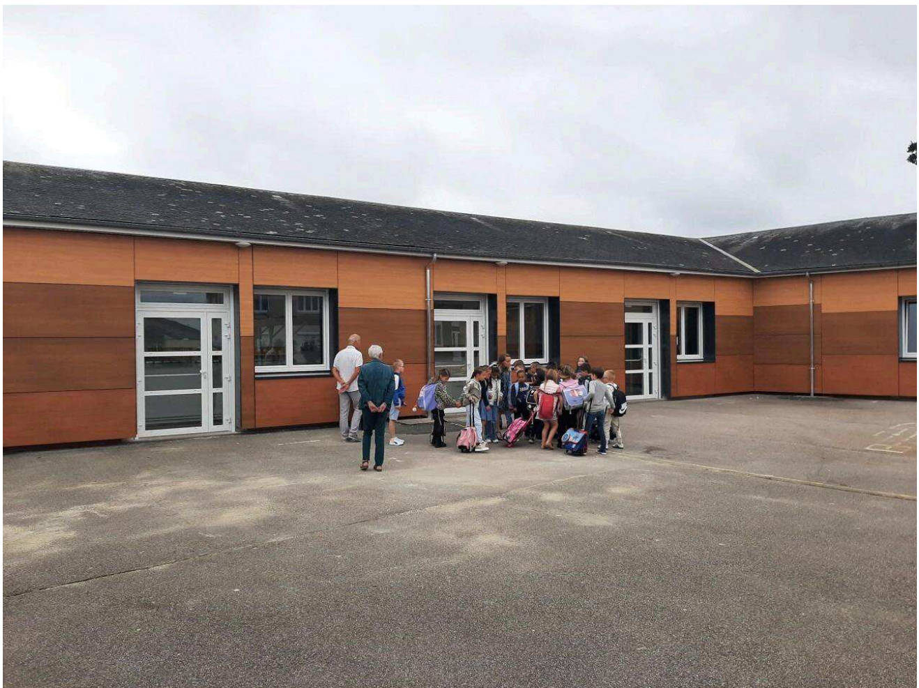
Le bâtiment de l'école originelle a été rénové entièrement.
