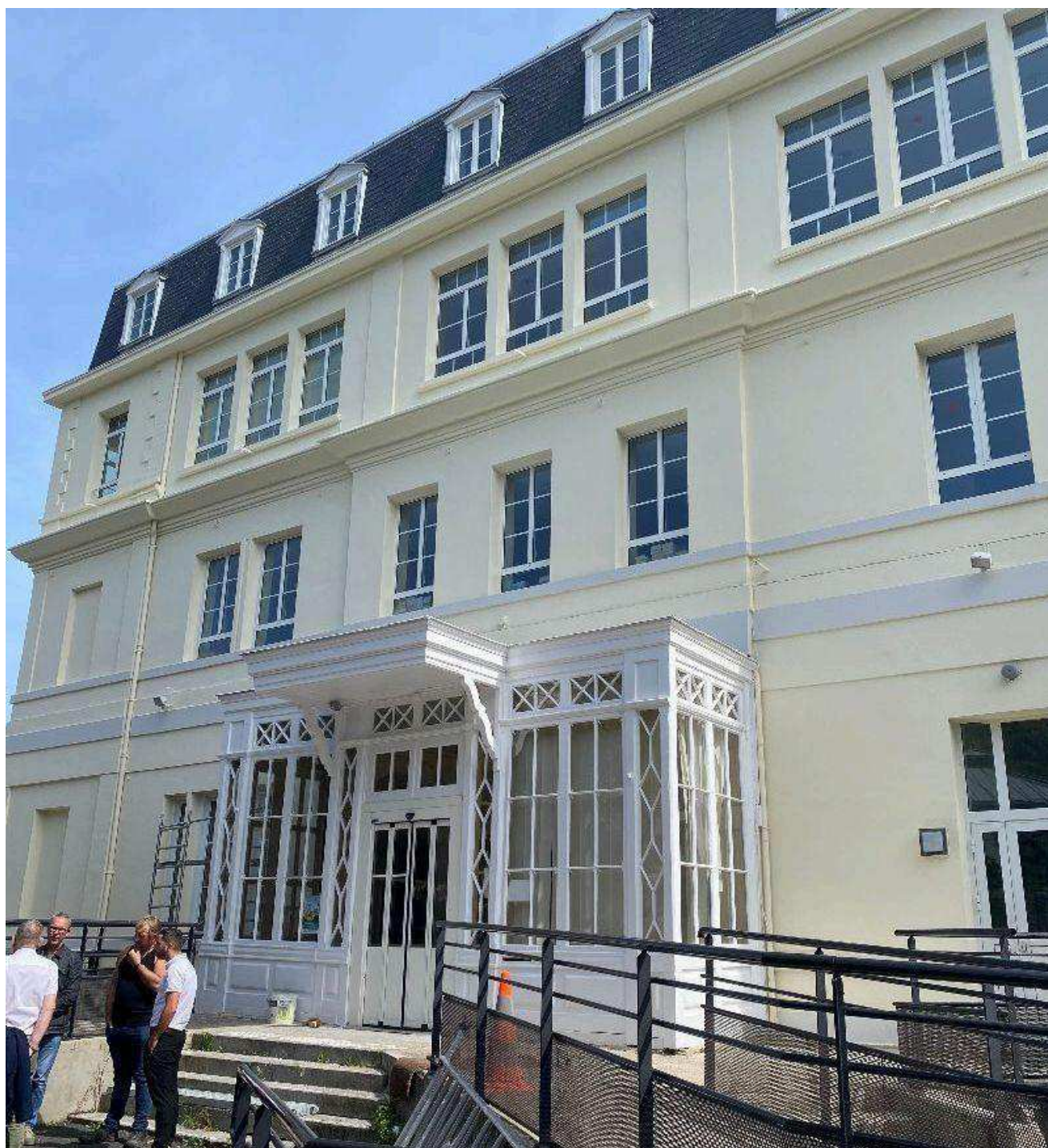
Un grand ravalement de façade est prévu à l'école du Bouloir. Fabienne Bouton
