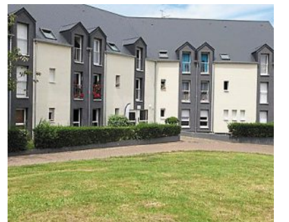
D'importants travaux énergétiques et une restructuration ont été réalisés à la résidence Les Clos-Clairs. | PHOTO : OUEST-FRANCE
