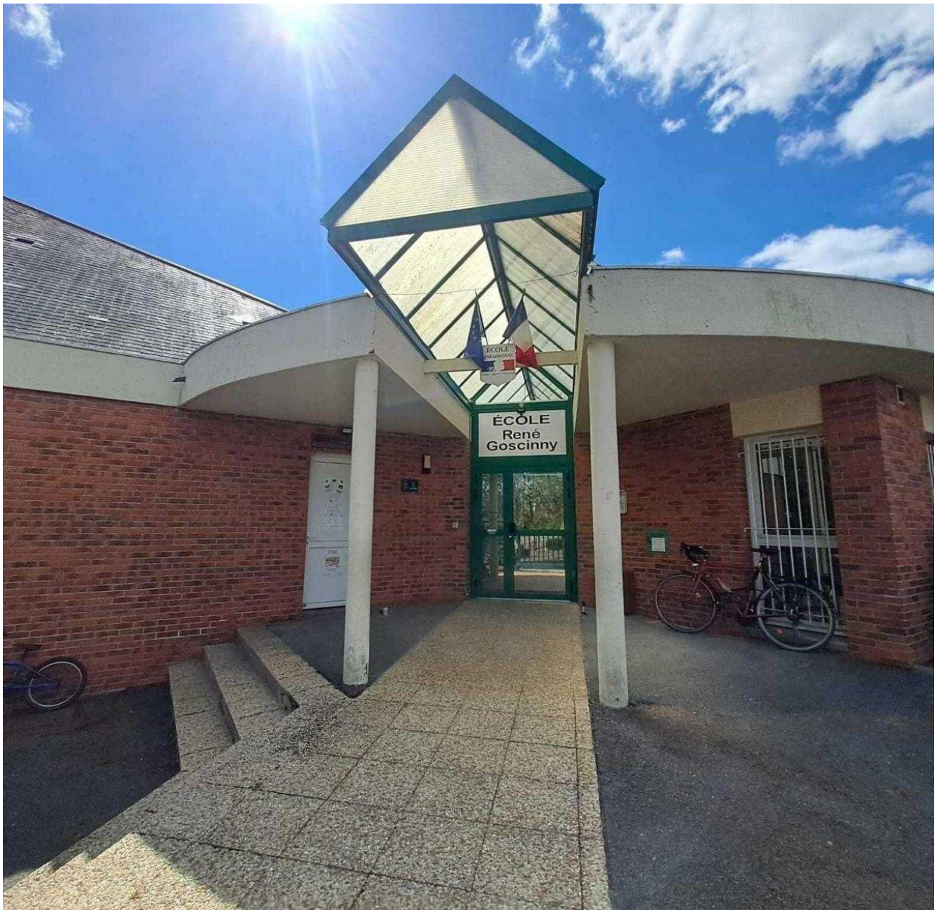
Saint-André sur Orne travaux école Grégory MAUCORPS
