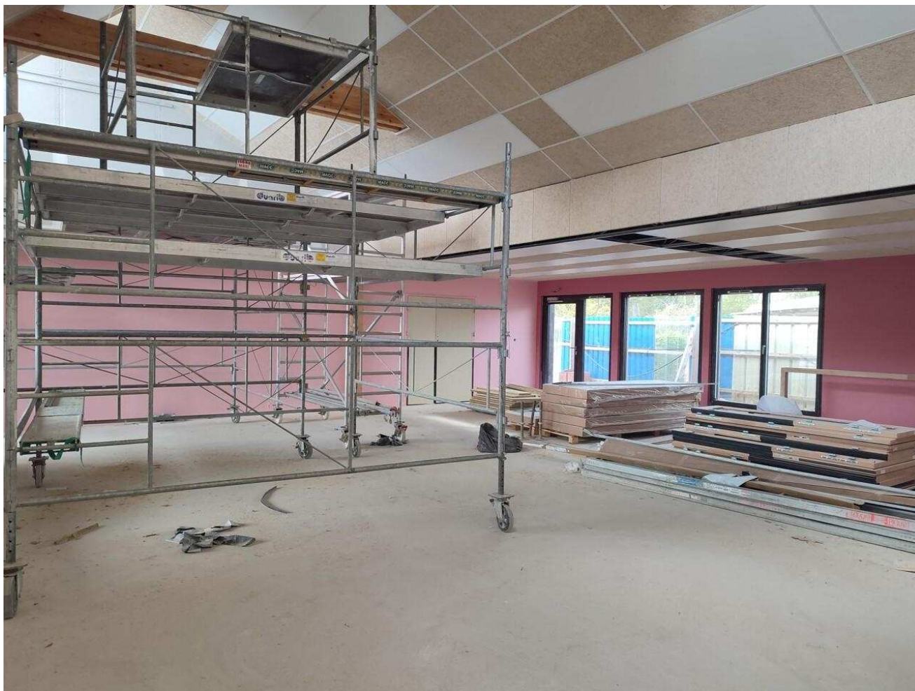
La salle de motricité en cours d'aménagement.
