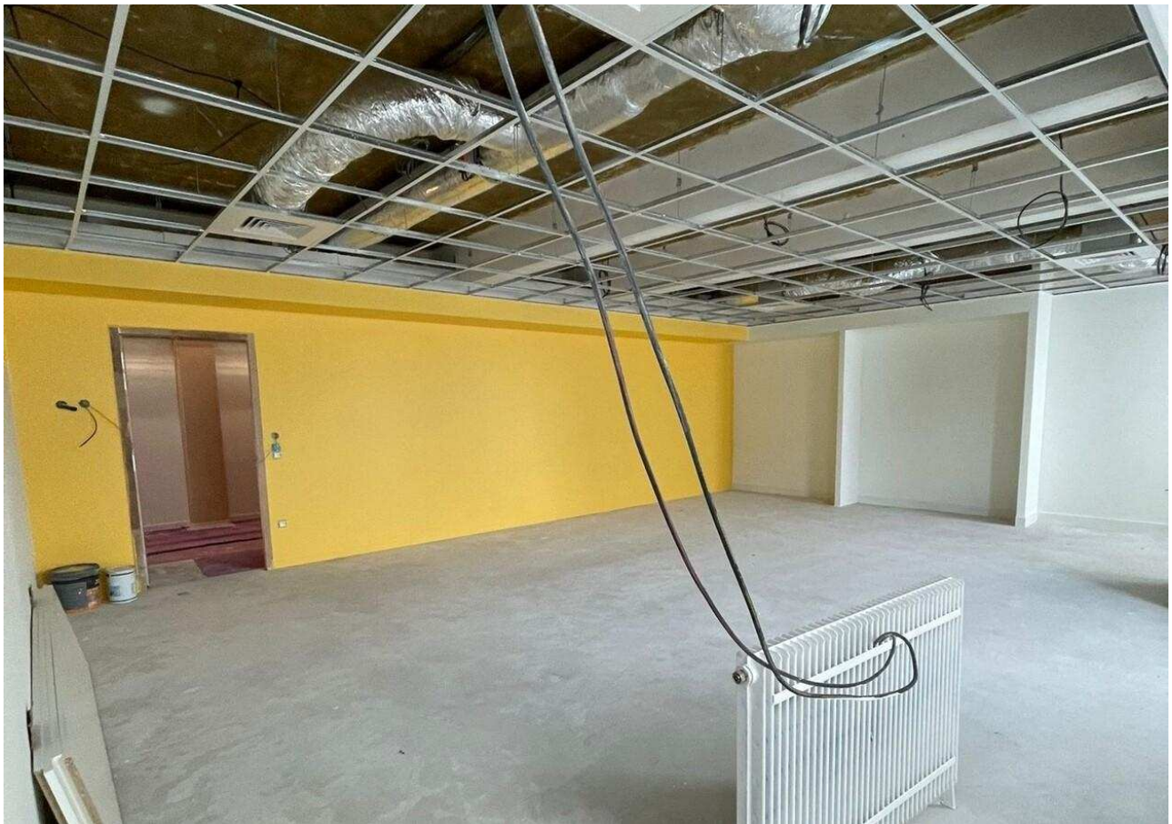
L'extérieur de l'école du Hameau Noblet, en travaux, à Cherbourg-en-Cotentin (Manche).
