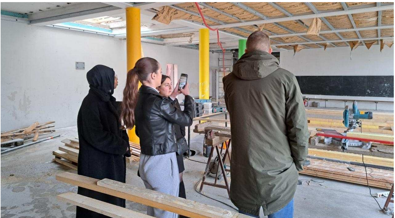
Les délégués des parents d'élèves ont été associés à la visite, pour observer l'avancée du chantier. Aurélien Delavaud
