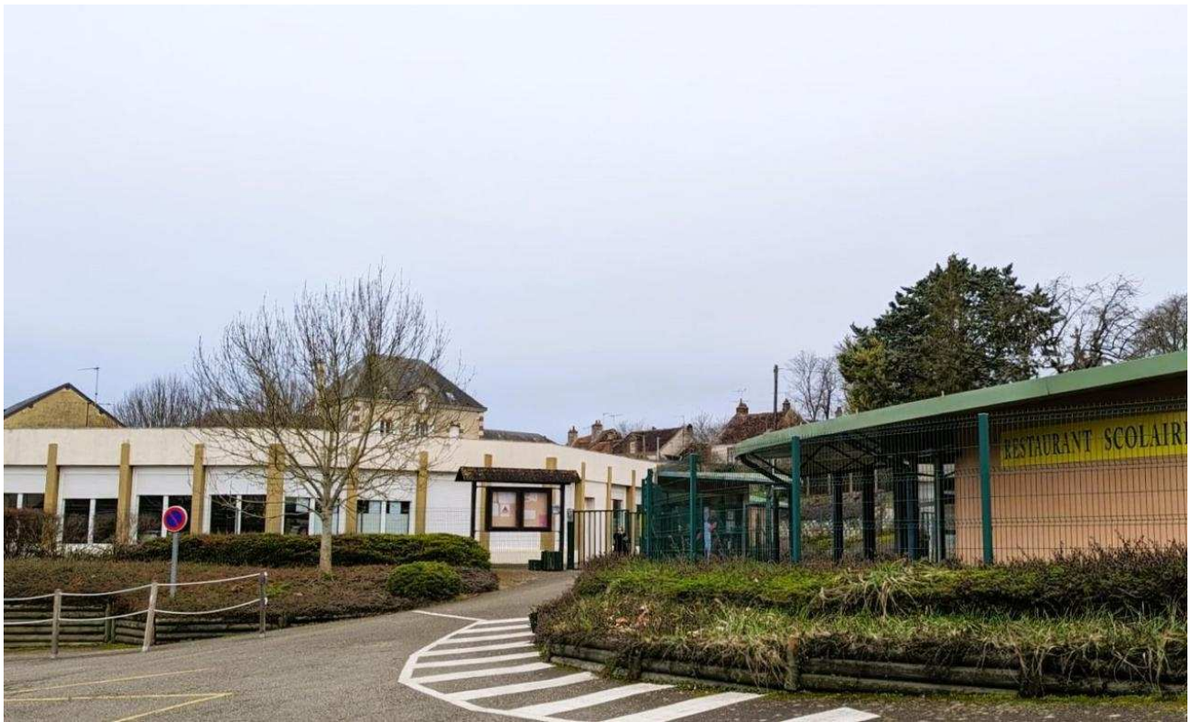
L'école rencontre, au cœur de l'hiver, des pannes de chauffage à répétition. Ouest-France
