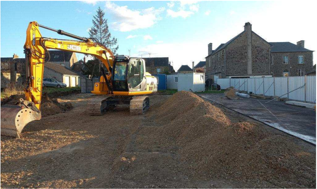
Dans la cour de l'école, les engins sont au travail.
