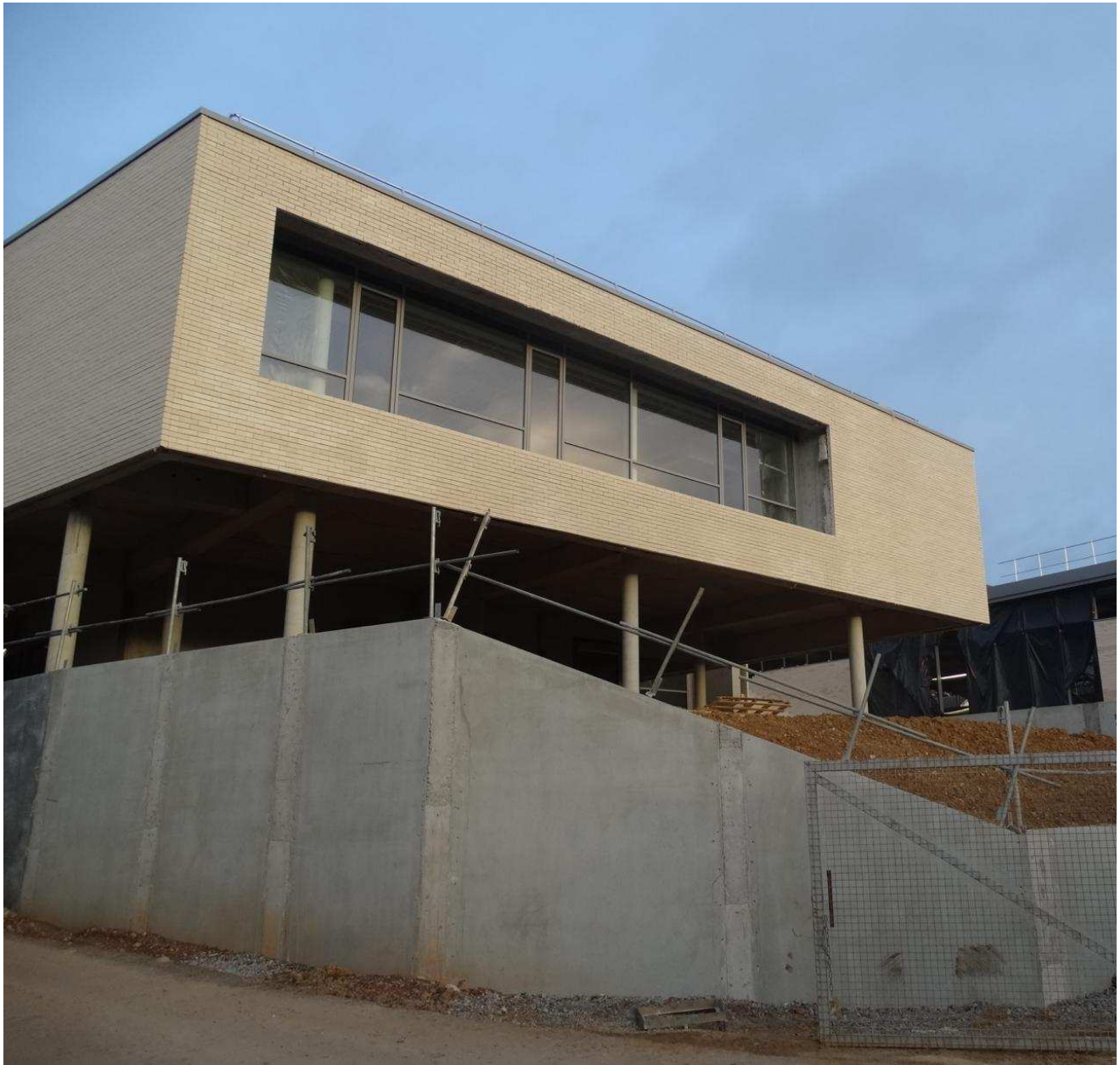
Ce sont des travaux d'envergure qui sont menés sur le site du lycée Clément Ader. Photo Philippe Wirton/Eveil Normand
