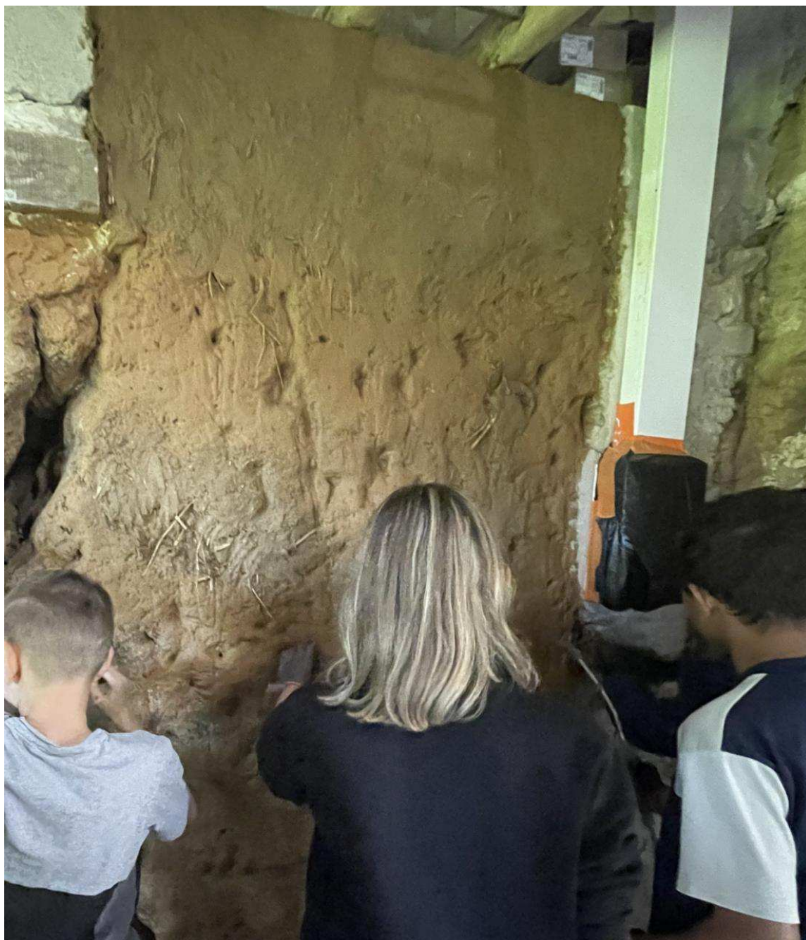
Les collégiens travaillent la terre en réparation de façade. Ouest-France
