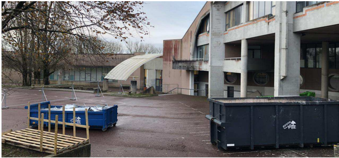
Une partie de la cour de récréation est inaccessible. Ouest-France
