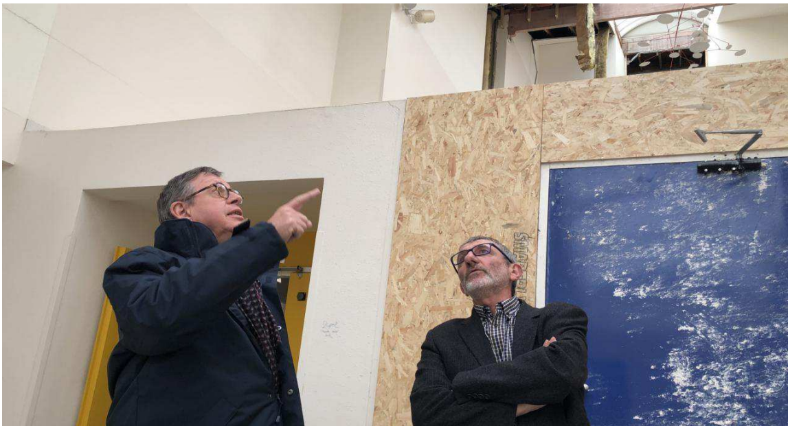
La verrière du collège Jacques-Prévert de Coutances qui s'était soulevée pendant la tempête Ciaran a été remise en place. Ouest-France
