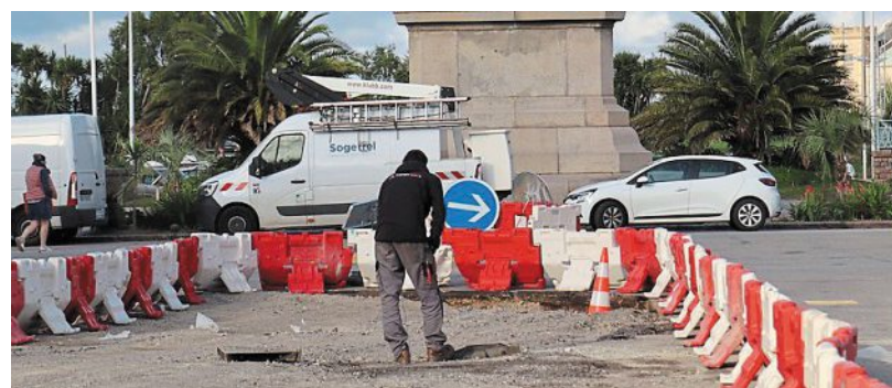
Un ouvrier de l'entreprise Sogetrel répare un câble coupé, pendant les travaux du Bus nouvelle génération (BNG), hier.
